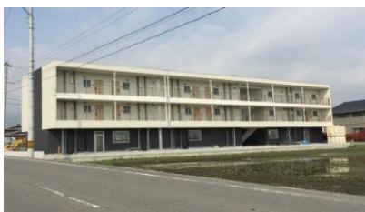
マキビル三重外観
